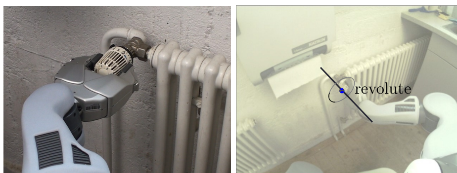
(d) valve of a heater
